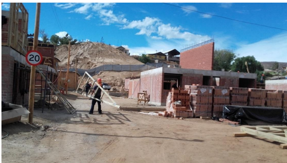
Imagen. Construcción de las viviendas.
