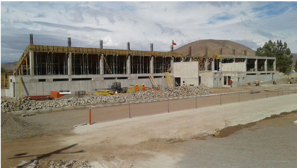
Imagen. Construcción fachada principal.
