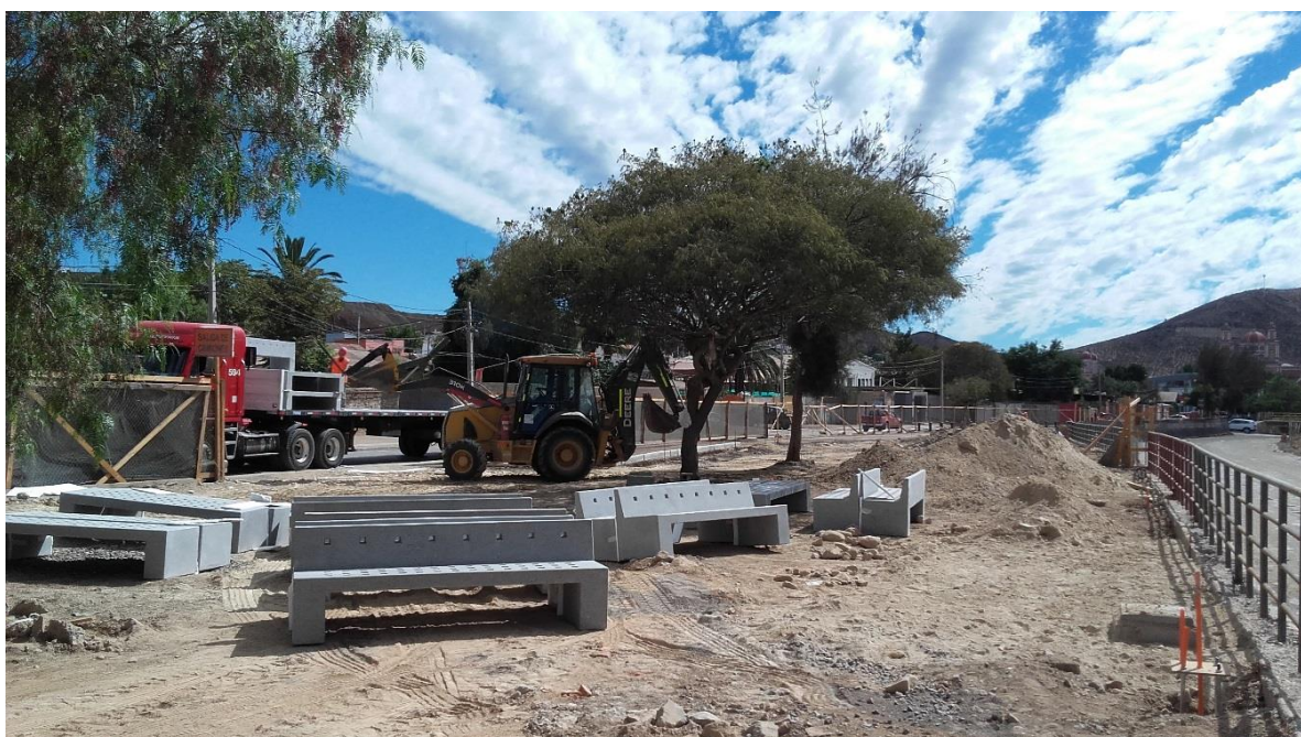
Imagen. Imágenes obra en ejecución.
