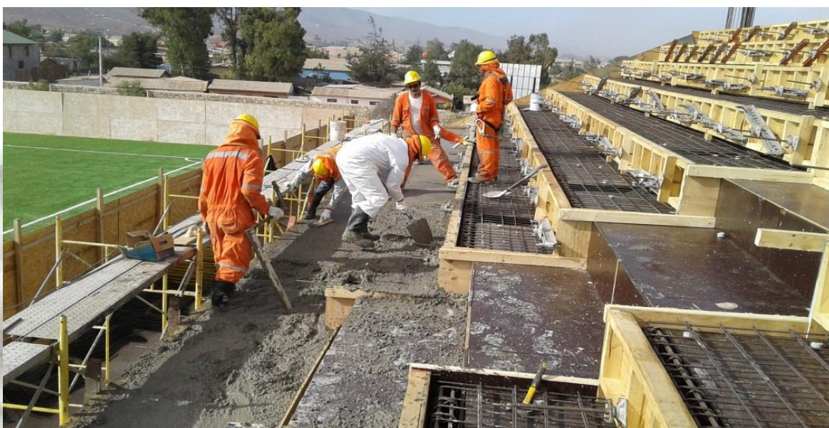
Imagen. Hormigonado de graderías.
