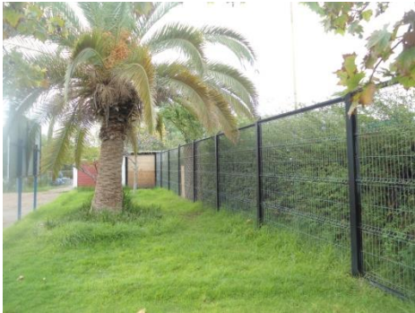
Mejoramiento Cierre Perimetral Piscina Parque Oasis.
