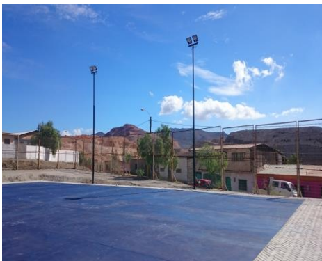
Construcción Multicancha Matadero.
