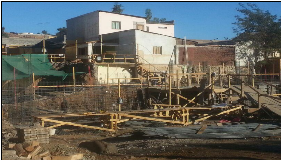
Estado actual de proyecto casa del encuentro ciudadano y gimnasio municipal.
