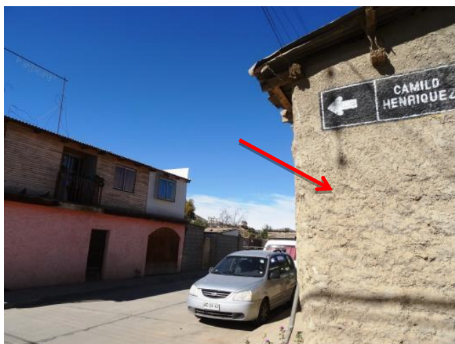
Foto 07: Vivienda en el centro de la Ciudad de Andacollo, construida en adobe.
