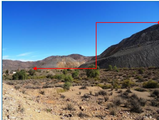
Foto 04: Altura (+/- 60 metros) del muro del relave contiguo y al norte de la localidad de El Toro.
