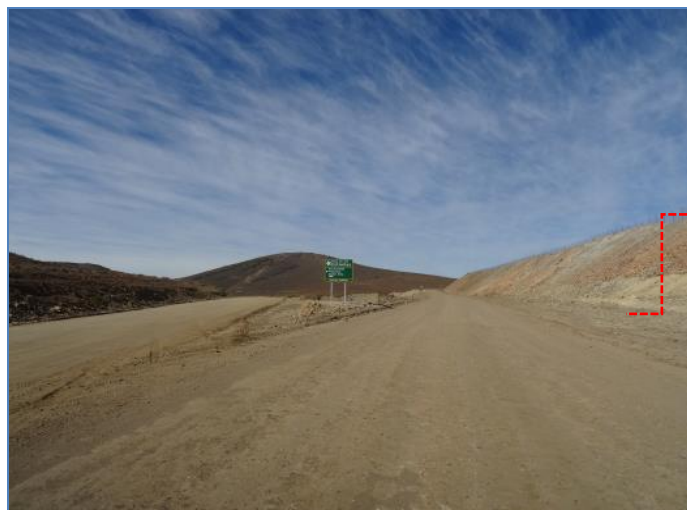
Foto 09: Vista del talud del relave actual que opera la Compañía Minera Teck Carmen de Andacollo.
